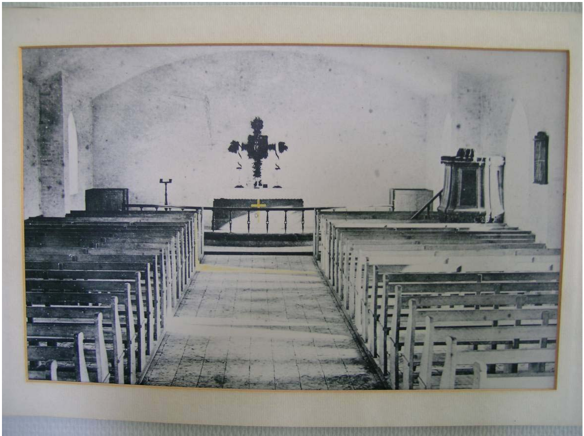
Kirkerummet i den første kirkebygning – opført i 1866.
